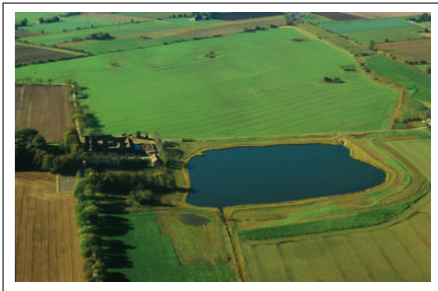
Anlagd bevattningsdamm vid Kristinetorp, biflöde till Kävlingeån, Eslövs kommun.
